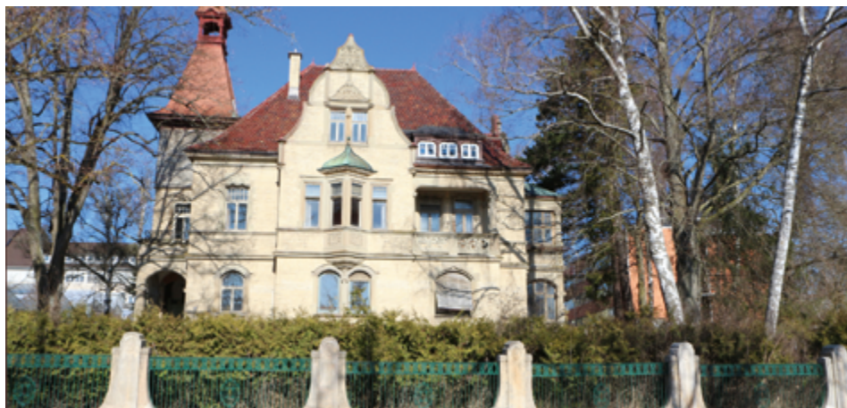
In dieses Gebäude sollen die Forschungsinstitute Sozialwesen und Wirtschaft einziehen.
